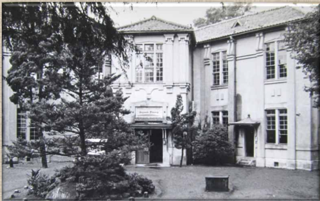
戦争による被災で大破した屋根の改修後 (昭和26年頃)
